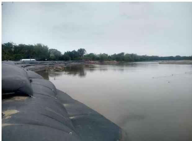
Fuente: Corporinoquia Abril del 2020. Vista longitudinal de la geoestructura instalada
